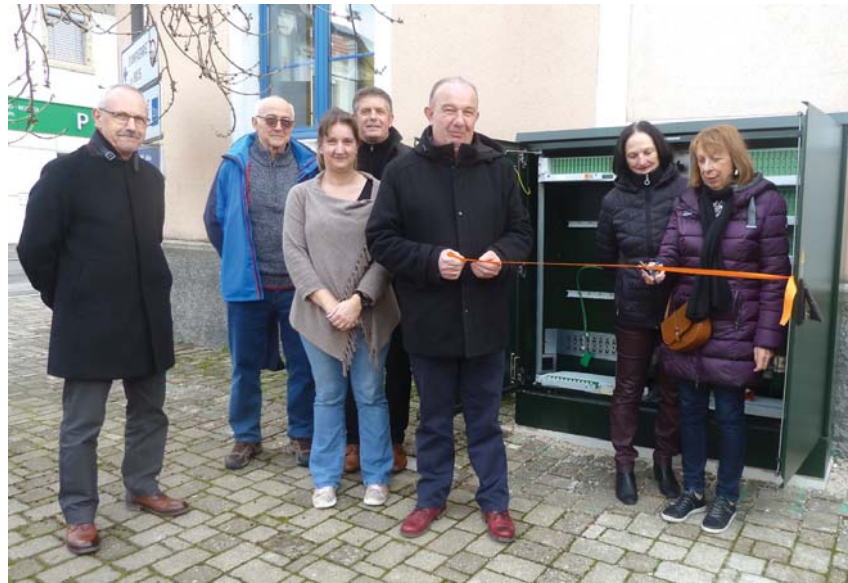
Inauguration de la fibre à Dasle.
